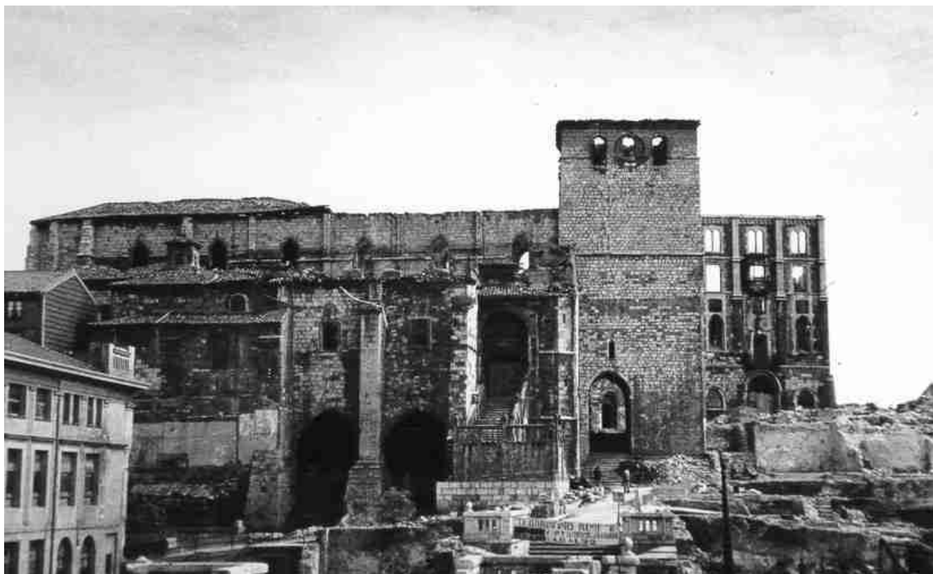
La Catedral, destruída. No se reabriría al culto hasta 1953, totalmente restaurada.
