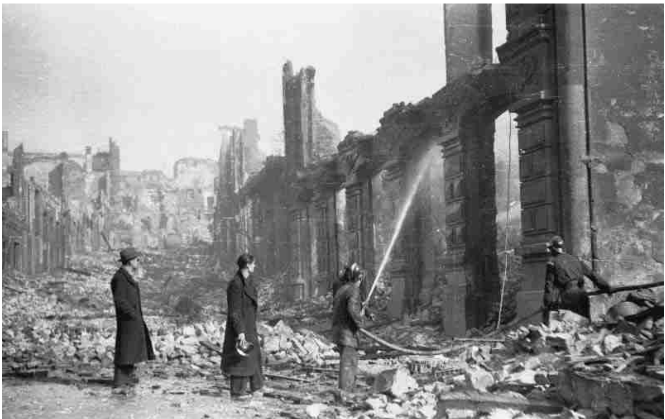
Los bomberos actúan sobre los rescoldos del incendio.
