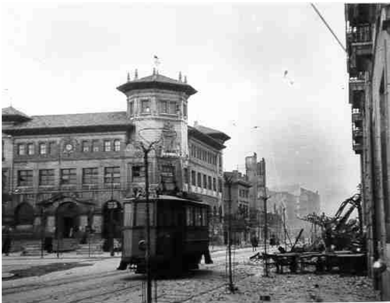
Edificio de Correos. Junto con el Banco de España, fue uno de los escasos edificios que se libró de las llamas dentro de la zona afectada.
