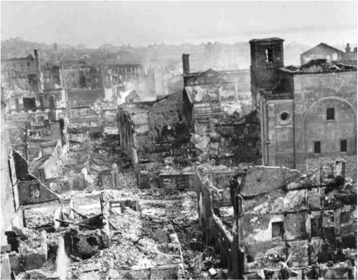
Estado en que quedó la calle Rualasal.
